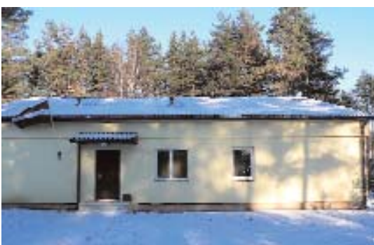
Īres nams Sēņu ielā 7 pirms renovācijas un pēc...
